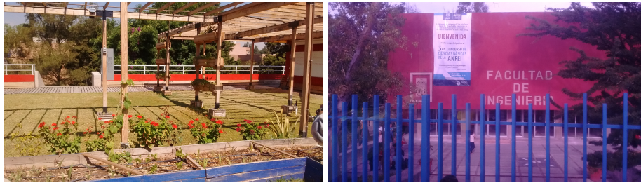
(a) Techo verde de un edificio del la Facultad
