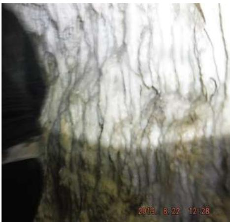
**Figura 5.** Recubrimiento de carbonato de calcio en las paredes del túnel
