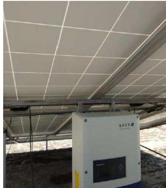
Figura 8. Instalación del Inversor marca KAKO de 3.0 kW dentro del sistema.
